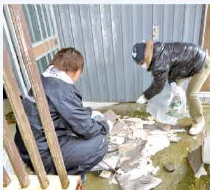
東日本大震災時のがれき撤去の様子
